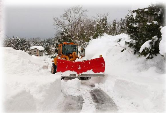
除雪作業の状況
