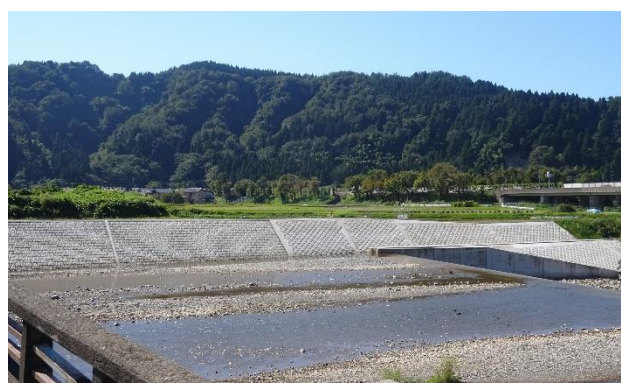
災害復旧事業により整備された護岸（令和2年）
